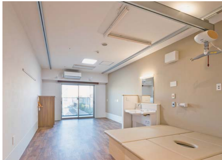
2階入所者居室。全室に自動ドアと天井走行リフトを設置
